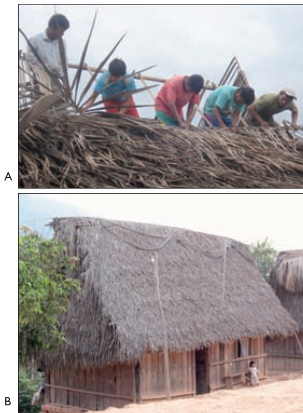
Figura 9. Proceso de elaboración y techado con hojas de Oenocarpus bataua en el municipio de Guanay A) tejido de las hojas en el lugar donde se quedarán, B) aspecto externo del techado terminado.
